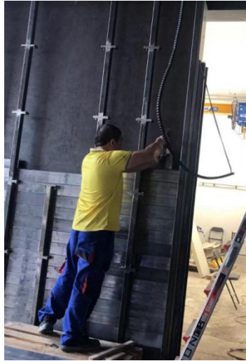
图 4 主照射面防护和进出通道防护施工图
