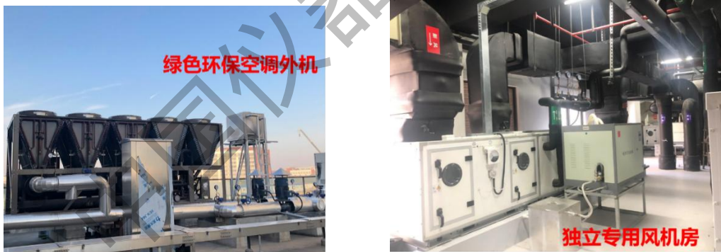
图2 空调外机和洁净空调箱的设备图
