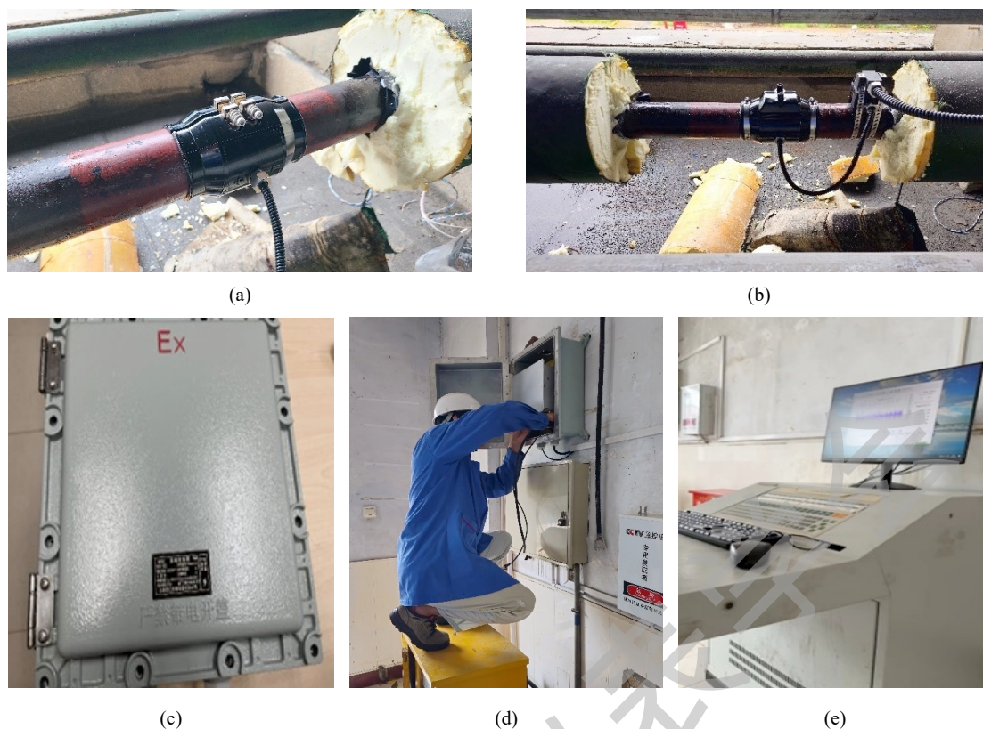
图 4 管道损伤监测系统现场安装情况。(a)传感器粘贴；(b)传感器及连接器固定；(c)防爆箱；(d)监测仪器安装；(e)上位机及系统调试。
